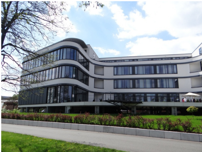
AENGEVELT begleitet die Telekom bei der Unternehmensexpansion am Standort Magdeburg und vermittelt dazu einen langfristigen Mietvertragsabschluss über rd. 1.800 m 2 Bürofläche in der Projektentwicklung "ElbArkaden - Otto-Hahn-Straße 1/Wittenberger Straße 17" im Entwicklungsgebiet Wissenschaftshafen. © Aengevelt Immobilien
