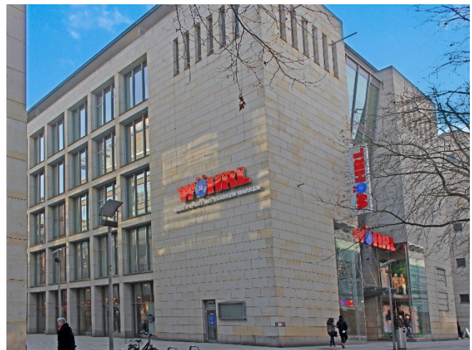
Das markante Büro- und Geschäftshaus „Wöhrl Plaza“ an der Prager Straße wechselte im Sommer 2017 den Eigentümer und wurde an die Hamburger Immobilieninvestmentgesellschaft DC Value verkauft.
